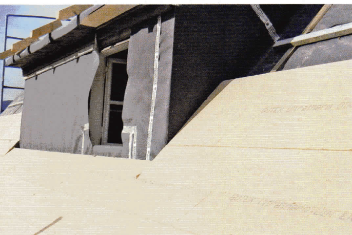
Die regendichten „Ultratherm“-Platten mit Nut und Federn bilden ein regensicheres Unterdach.
