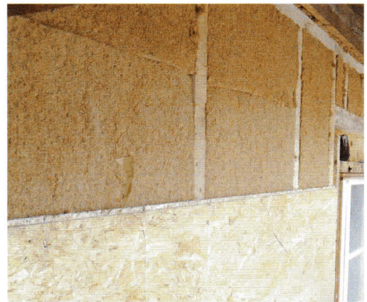
Die flexiblen „Thermoflex“-Dämmplatten lassen sich einfach in die Gefache einklemmen.
