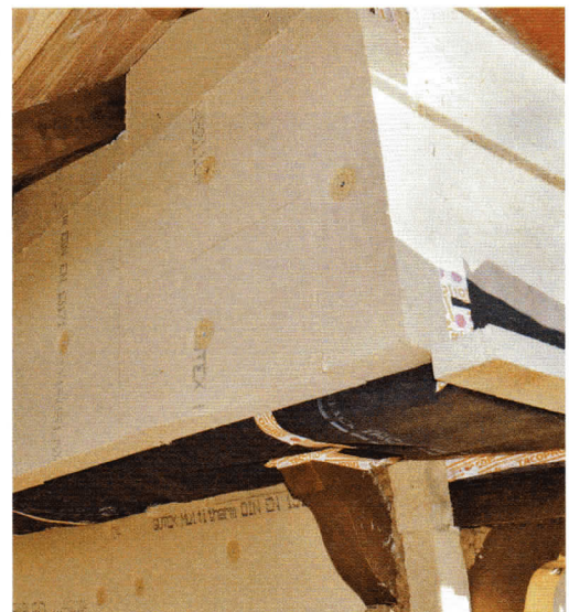
Die feuchteunempfindlichen „Multitherm“-Platten eignen sich bestens für hinterlüftete Fassaden.
