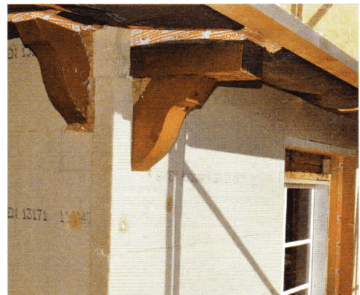
Auch die Fensteranschlüsse und -laibungen müssen fachgerecht überdämmt werden.
