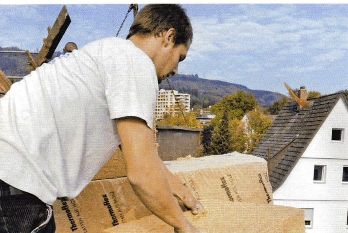
Bei Sanierungen im Dach ist es hilfreich, wenn sich die Dämmplatten einfach an unregelmäßige ...
