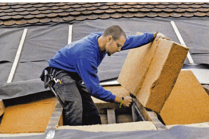
... Formen und Größen anpassen lassen, wie mit dem handlichen „Thermoflex“-Messer.
